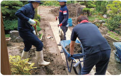
土砂出しの様子
